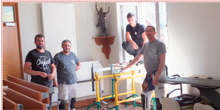
Rénovation des fenêtres de la mairie avec les entreprises B. Ducher et D Delpuech
