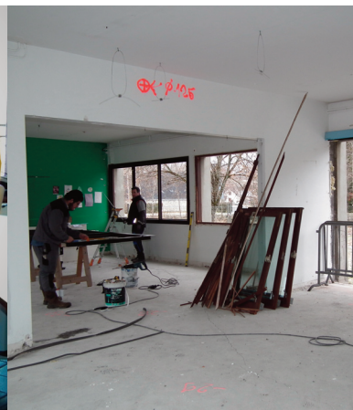
En février, les travaux à la micro-crèche.
